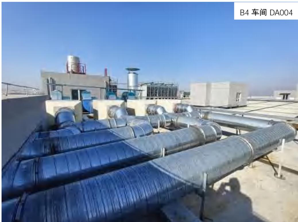
图 4-2 有机废气处理设施
