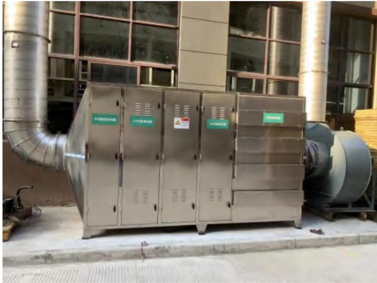
图4-2 本项目涂胶烘干废气处理设施图片
