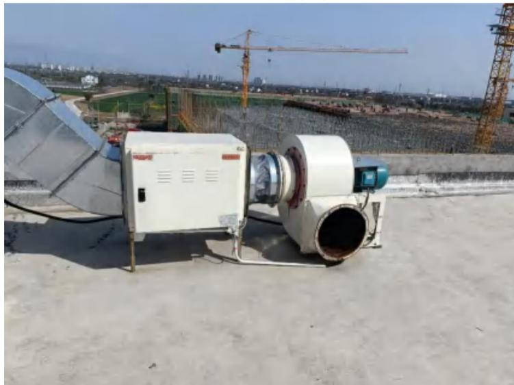
图4-3 本项目食堂油烟废气处理设施图片
